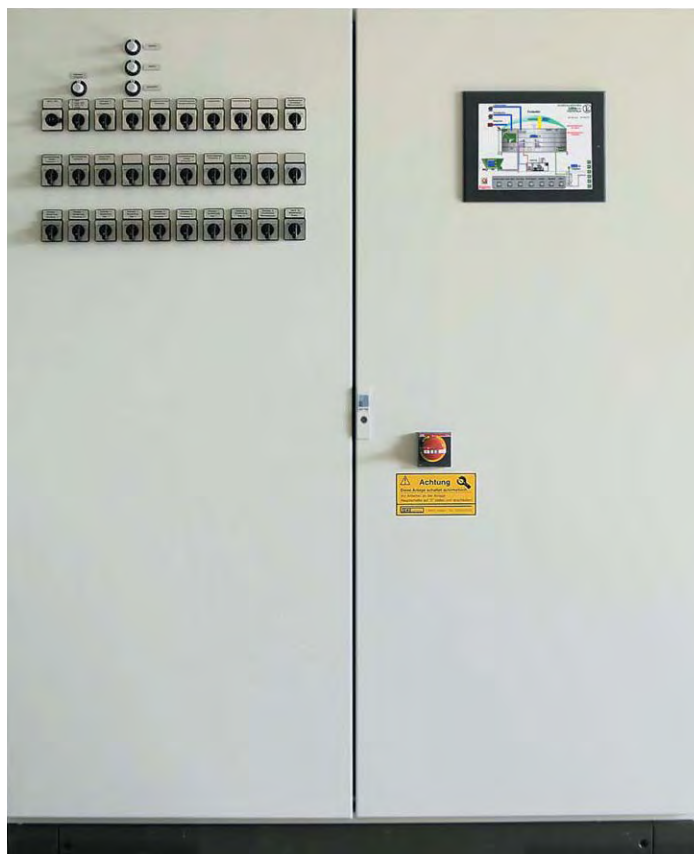
Inima și creierul instalației de biogaz: Unitatea de comandă centrală, cu display
