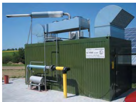
Bloc cogenerare în container – compact, izolație fonică și instalare rapidă
